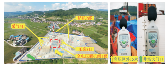
图5 全电压裂施工井场布置
